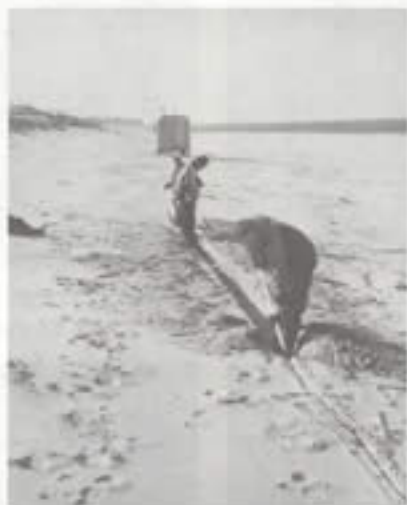
Die erste Gruppe setzte Sandfangzäune, um der weiteren Erosion der schützenden Dünen in diesem Bereich entgegenzuwirken.
